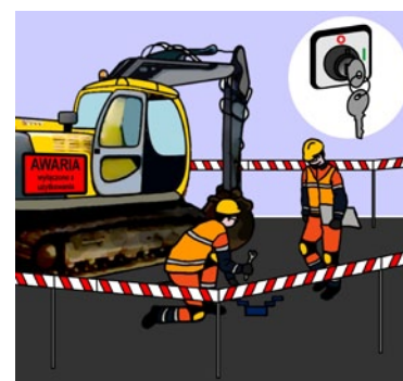
Rys. 3. Miejsce prowadzenia napraw i remontów maszyn
